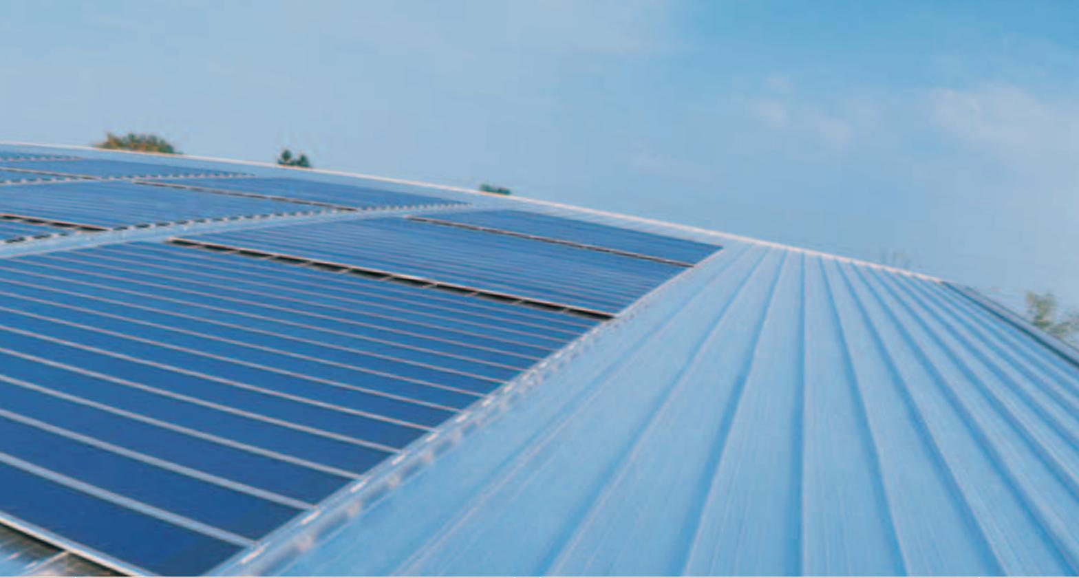
En la arquitectura con instalaciones fotovoltaicas se diferencian dos sistemas, el denominado sistema aditivo y el sistema integrado en la cubierta (BIPV). Para ambas alternativas Corus ofrece soluciones de colocación solar aplicable de manera óptima sobre las bandejas Kalzip.
